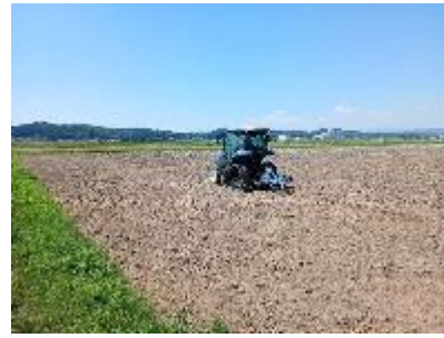
写真5 カットドレンによる 補助暗渠施工(タマネギほ場)
