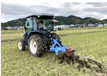
補助暗渠施工作業 (カットブレーカー)
