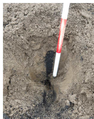
写真6 削溝充填後のバイオ炭
