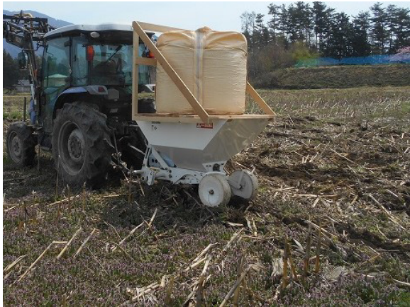
モミ殻暗渠施工の様子
